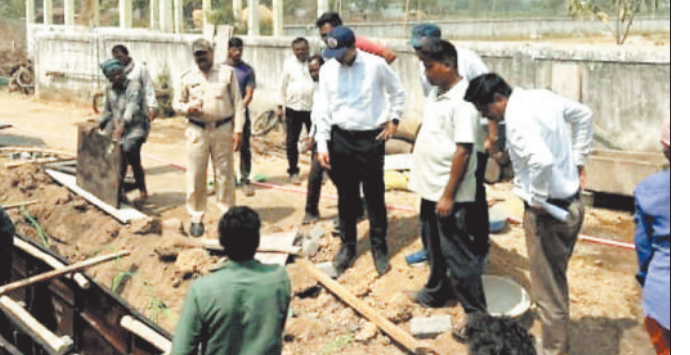
निर्माण कार्यों का निरीक्षण करते जिला पंचायत सीईओ।
